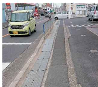
溝蓋が撤去されて安全になる予定の歩道
