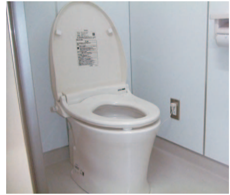
市内学校施設の、改修された洋式トイレ
