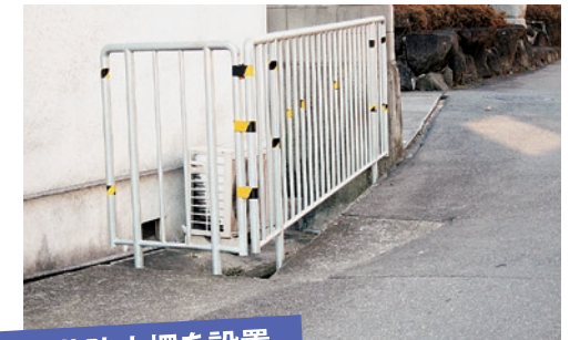
転落防止柵を設置
