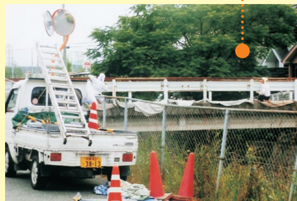
大乘川の2つの橋のサビの改修工事
